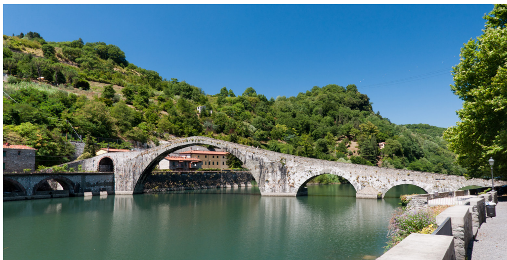
- BORGO A MOZZANO (LU) - PONTE DELLA MADDALENA -
